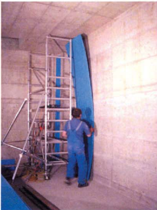
Sanierung: Montage der Stegprofilplatten
