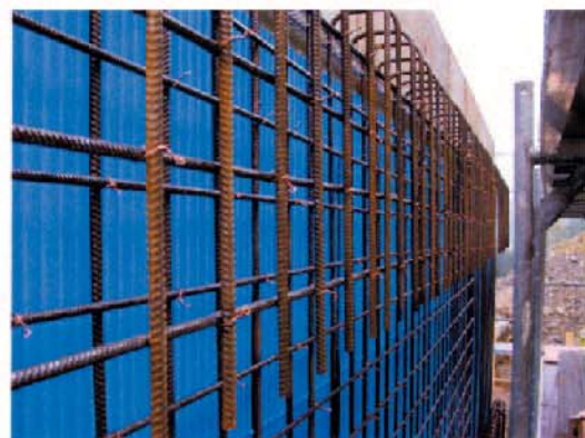
Neubau: Rückseitige Stege mit Armierung
