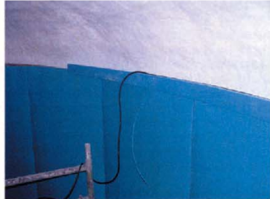
Wandmontage mit Abschlussprofil und Dichtung
