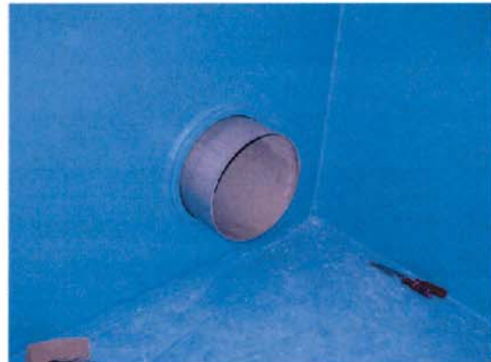
Wanddurchführung in Stahl eingebunden in Polyethylen
