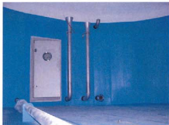
Rundes Reservoir mit Drucktüre und Stahlverrohrung
