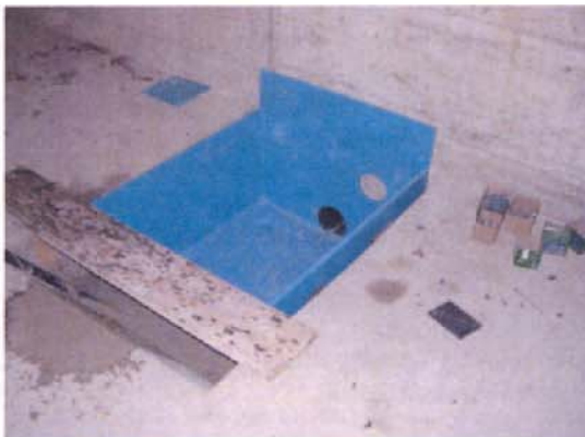
Vorfabrizierter Pumpensumpf mit Entleerungsleitung
