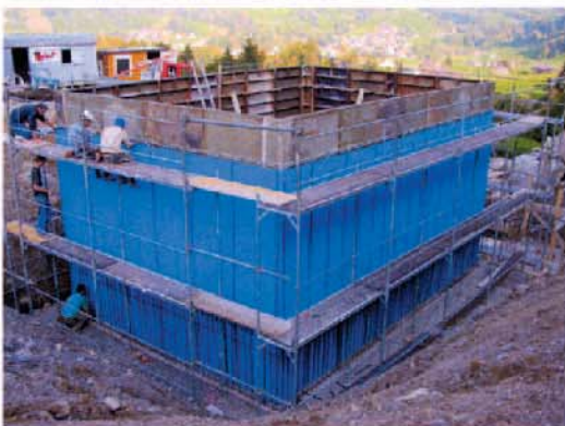
Neubau: Montage der Stegprofilplatten auf der Schalung
