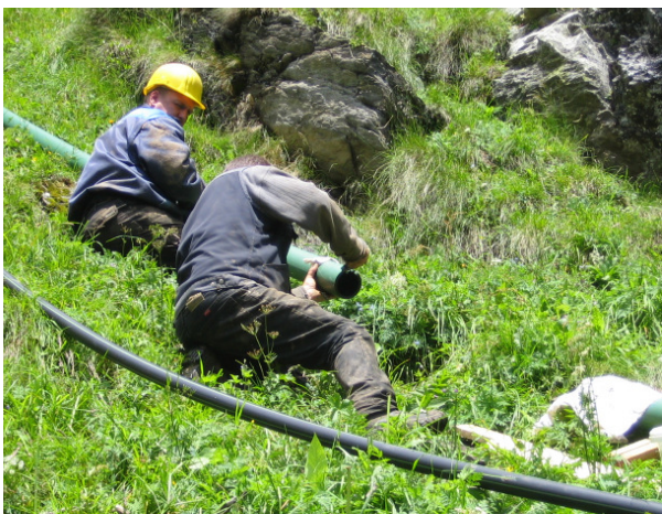
Bild 3: Verlegung im Steilhang zur Innsbrucker Hütte bei 100% Gefälle. Höchste Anforderung an Mensch und Material!
