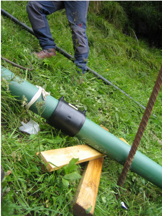
Bild 7: Verschweißen der Rohrstränge mittels Heizwendelformteilen.
