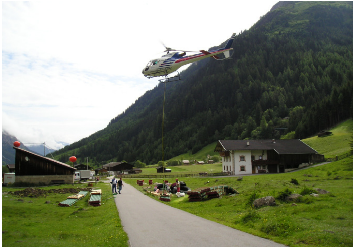
Bild 4: Materiallager im Tal. Alle Materialien wurden in Gebinden, die an die Traglast des Helikopters angepasst waren, geliefert.
