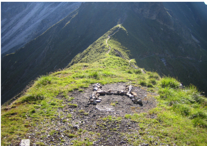
Bild 5: Speziell markierte Plätze zeigten dem Piloten die Abladestellen entlag der Trasse.
