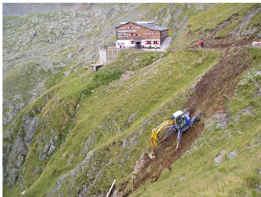
Bild 8: Innsbrucker Hütte mit östlichem Steilhang. Bei 100% Gefälle zieht ein Schreitbagger den Rohrgraben
