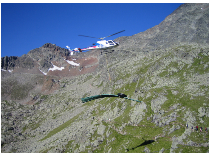
Bild 6: AGRU-FRANK Sureline II Rohre beim Anflug auf die Baustelle in den Stubaier Alpen
